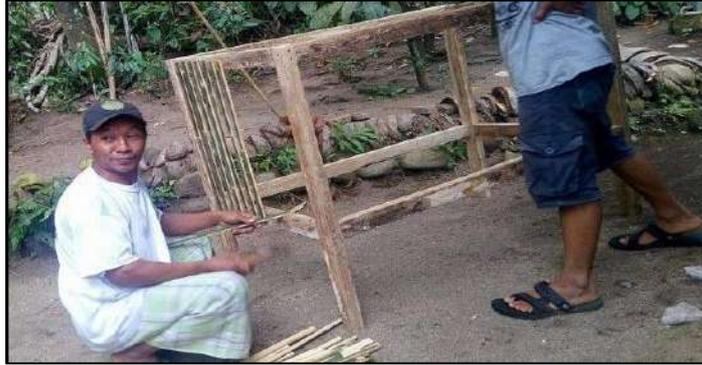
**Gambar 1.** Proses Pembuatan Rangka Kandang
